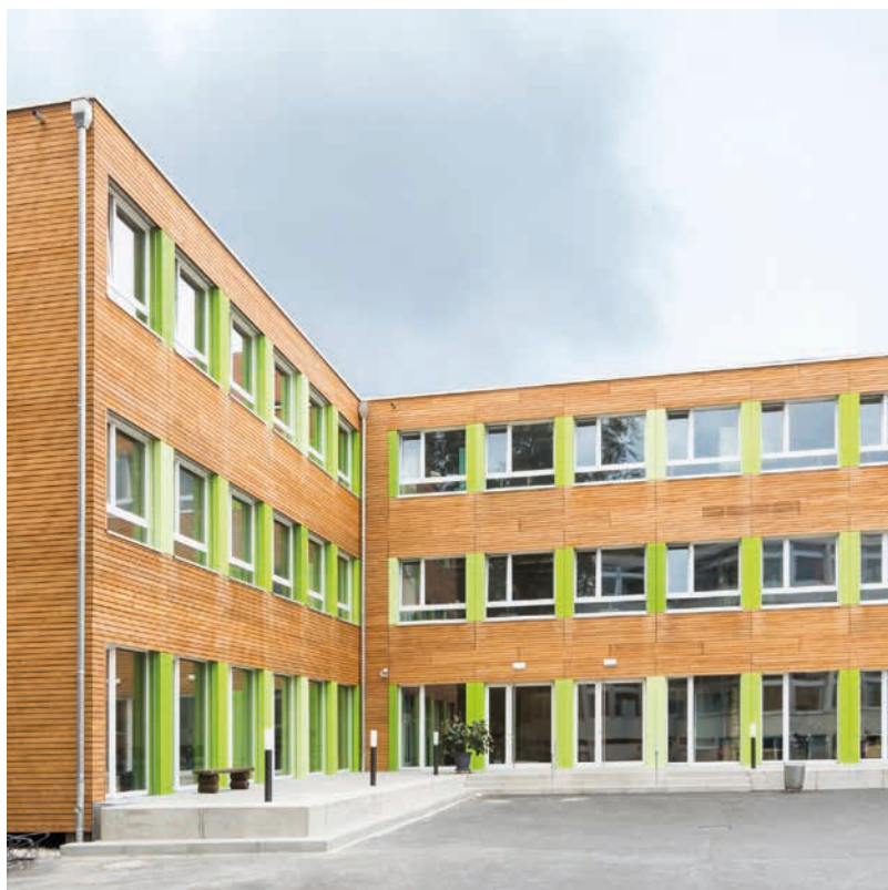
Schulgebäude in Nürnberg | ERNE AG Holzbau
