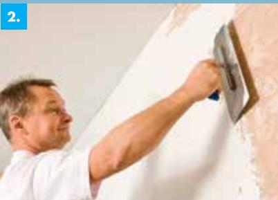
**Auftragen:** Den Rotkalk Oberputz in der laut technischem Blatt vorgegebenen Dicke auf den Unterputz auftragen und mit der Traufel oder Glättkelle eben verziehen. Das beste Ergebnis wird bei einem volldeckenden Auftrag in Kornstärke erreicht. Die erste Lage zunächst antrocknen lassen, dann eine zweite Lage auftragen und eben verziehen.
