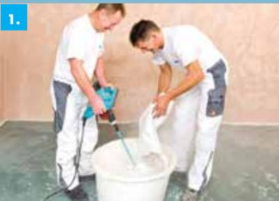
**Anmischen:** Bei Handverarbeitung den Sackinhalt mit der vom Hersteller angegebenen Menge sauberen Wassers ohne weitere Zusätze anmischen. Bei maschineller Verarbeitung ist die Wasserzugabe konsistenzgerecht einzustellen.
