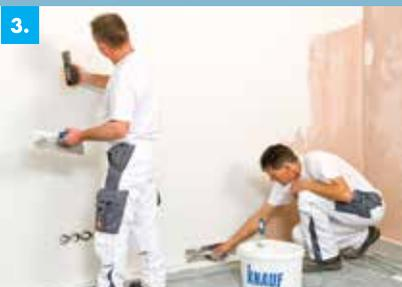
**Filzen:** Das frische Material kann anschließend ohne zusätzliche Zugabe von Wasser mit der Rotkalk Schwammscheibe abgerieben oder gefilzt werden. Zusammenhängende Flächen sollten am selben Tag fertiggestellt werden.
