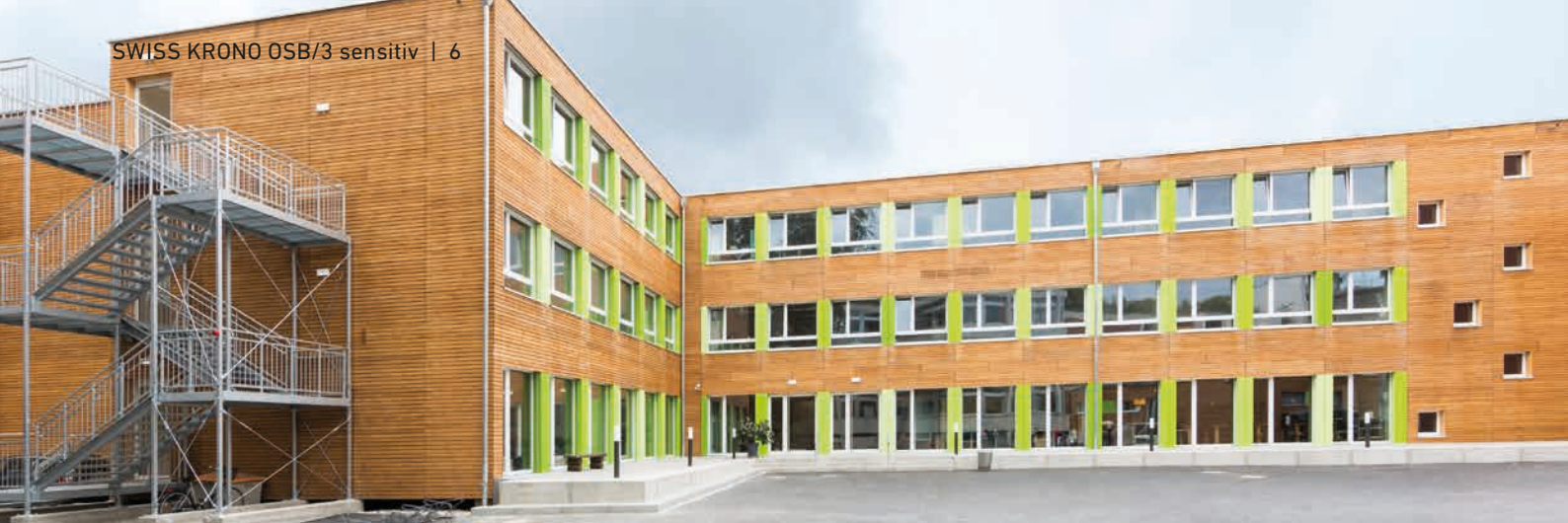
ERNE AG Holzbau, Maria-Ward-Schule, Nürnberg
