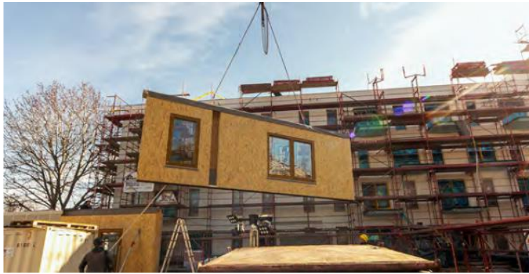
Montage der Wandelemente aus SWISS KRONO OSB
